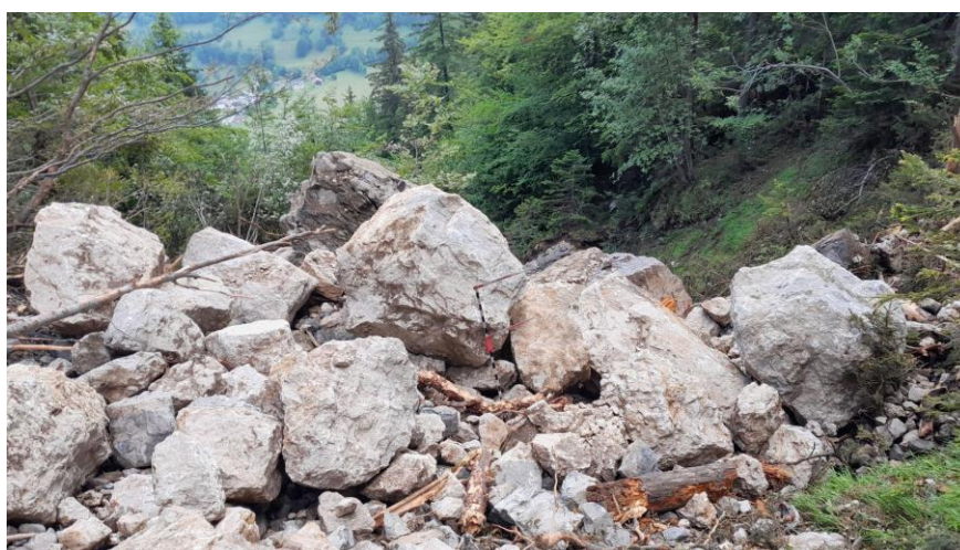
Figure 12 : amas de blocs dans le haut du talweg (2023©RTM-PhC)
