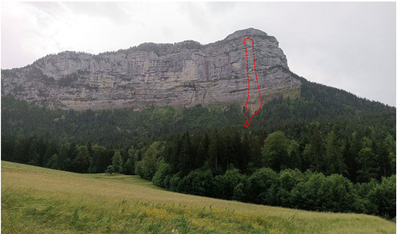
Figure 3 : vue éloignée de l'éboulement (2023©RTM-GL)
