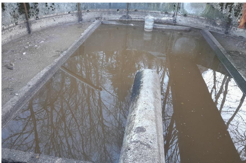
Décanteur-digesteur
