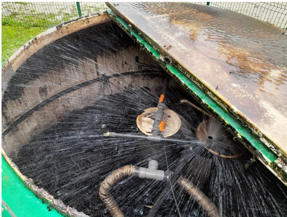
Lit bactérien durant l'alimentation (buses de gauche bouchées)
